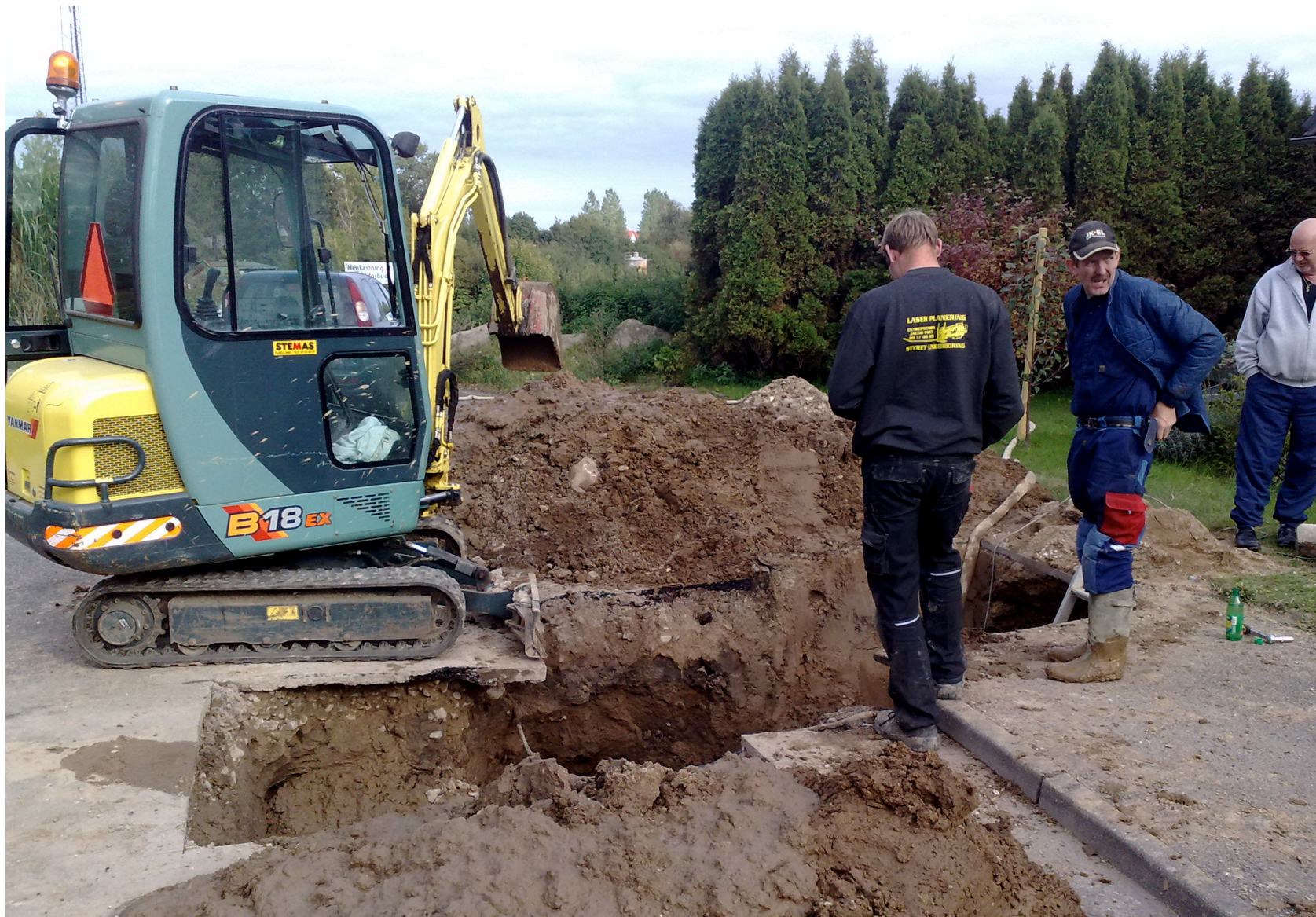
Smedemester Erling Jensen, Skov-Hastrup i færd med at reparere en vandledning, 2008
