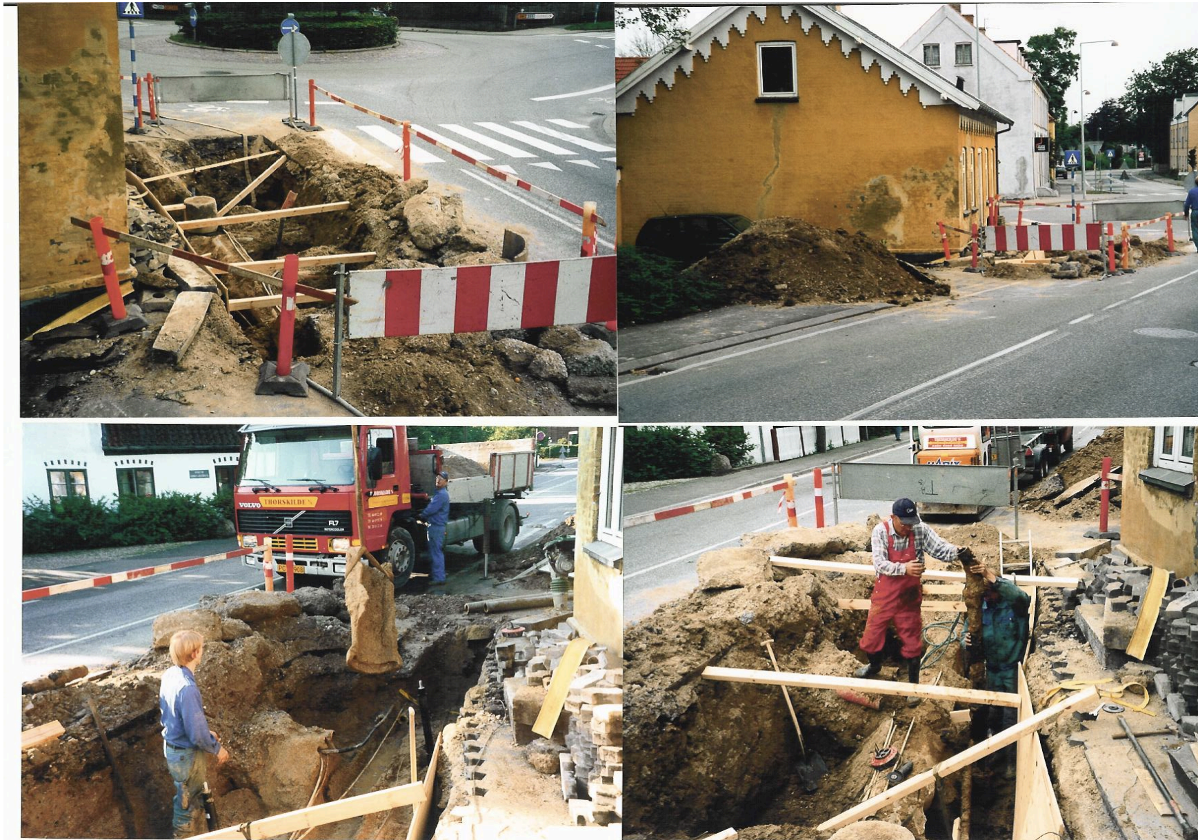
Ledningsbrud ved den gamle lægebolig, 2003
