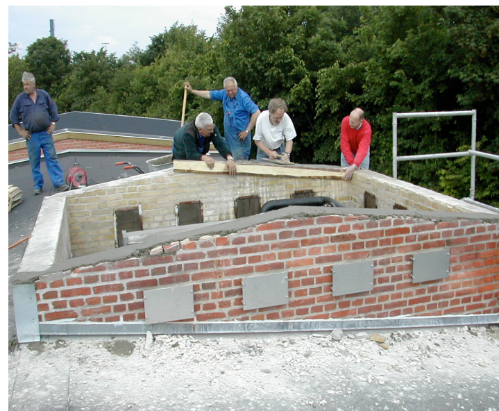
Reparation af iltningstårnet, 2004
