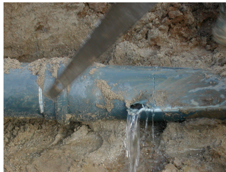
Brud på råvandsledningen, 2004
