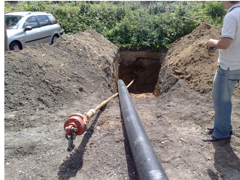
Ringledningen føres under jernbanen, 2008
